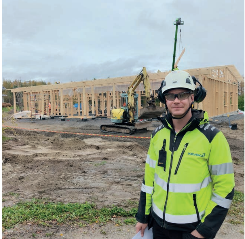
Mika Majava, vastaava työnjohtaja Keveka Rakennus Oy
